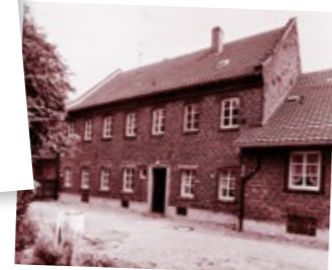
das ehemalige Verwalterwohnhaus, heute Verwaltung
